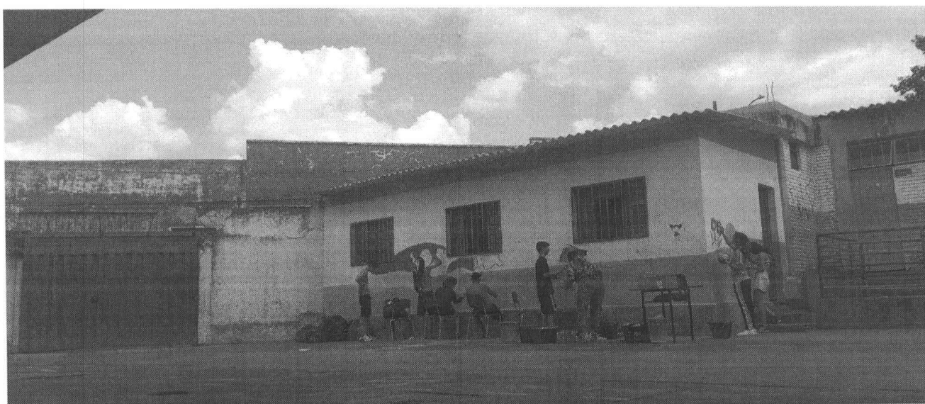
Foto 2: Primeira etapa da pintura no muro, Contagem, 22/11/2023
