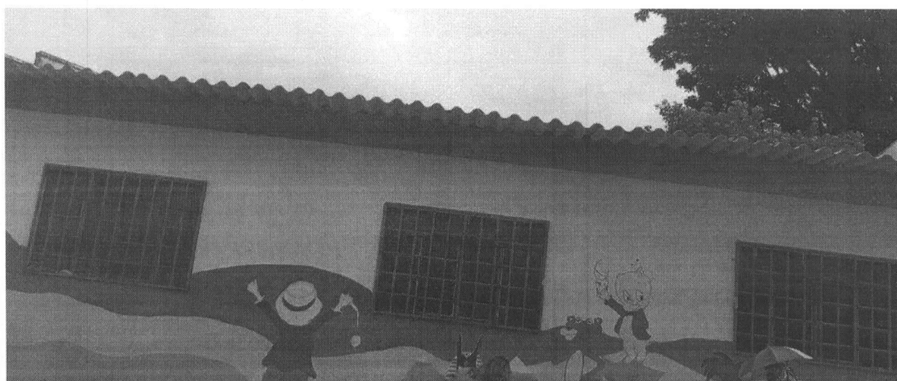
Foto 2: Terceira etapa da pintura no muro, Contagem, 29/11/2023
